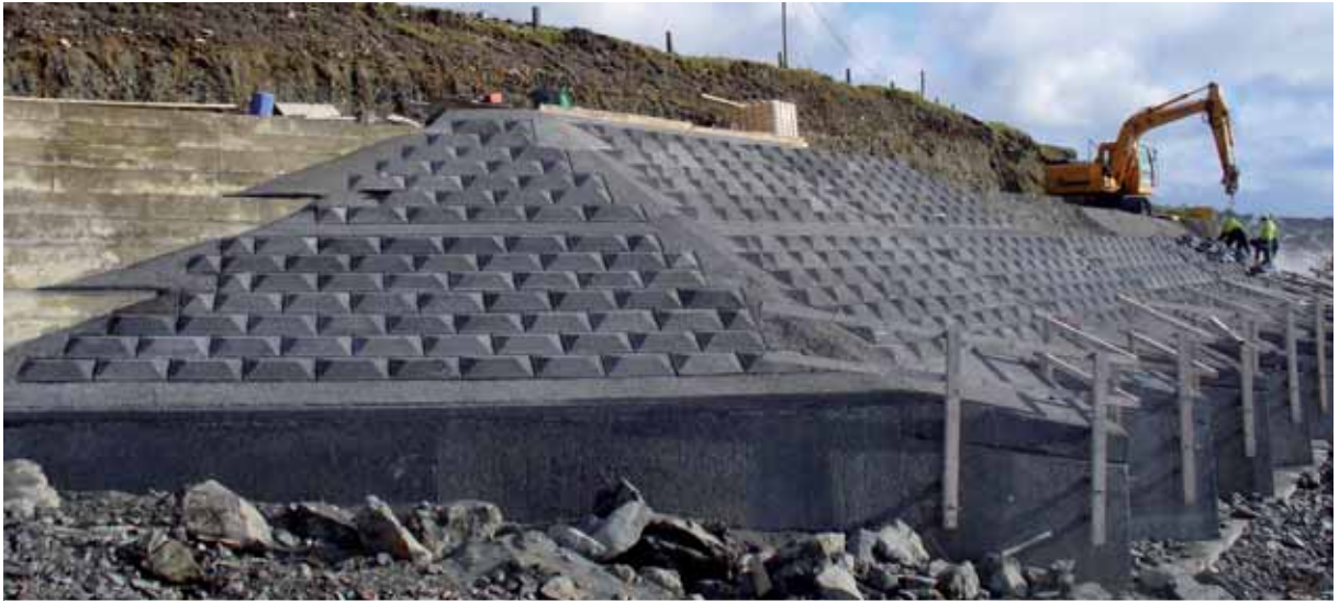
Oibreacha Cosanta Cóta ar Chladach ó Dheas Inis Bó Finne
